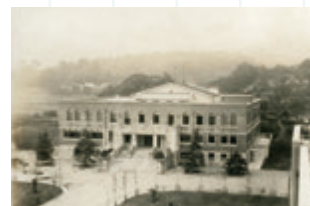
▲正面に4本の木があった頃の図書館。
