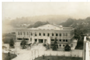
▲正面に4本の木があった頃の図書館。
