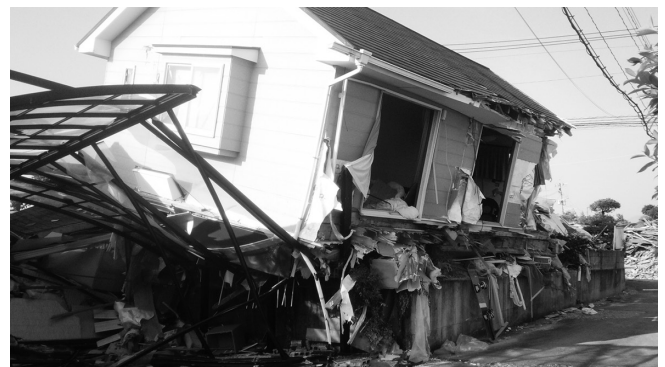
2016年熊本地震発生直後の被災地の様子（筆者撮影）
