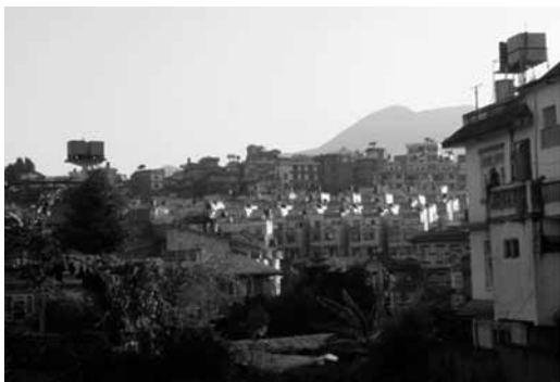
住宅建築が進むカトマンズ
